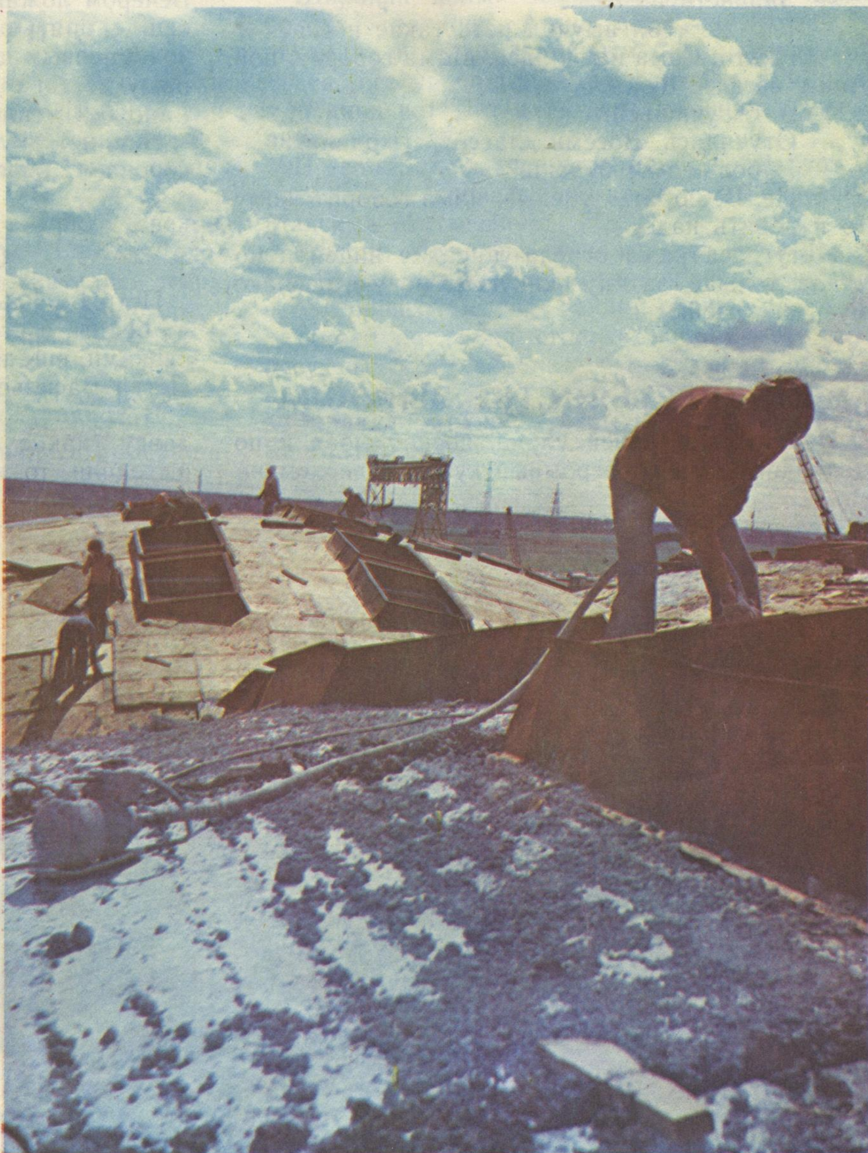
Михаил Лажин занят бетонированием перекрытий склада.
